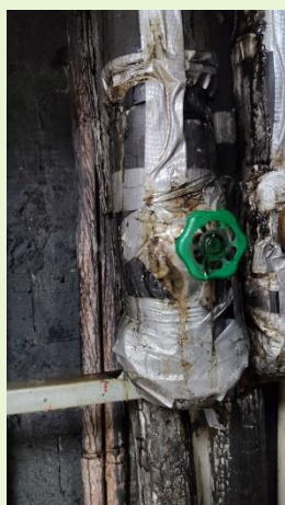
Detectados vazamentos na tubulação do Chiller do Bloco E que vai requerer desligamento do sistema em data a ser definida
