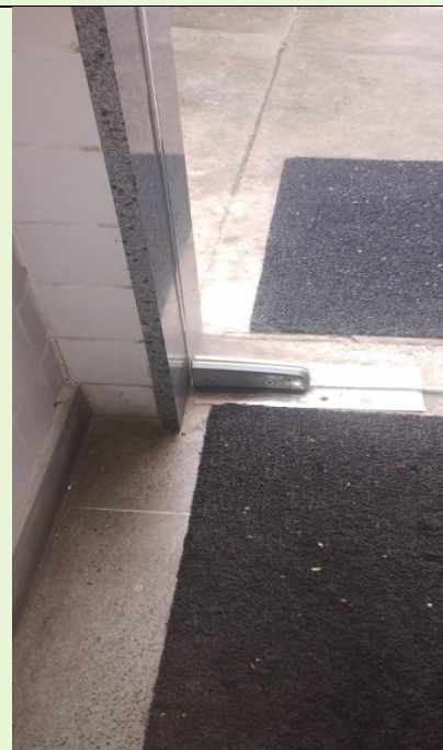
Reparo na porta do Bloco E feito por colaborador da Spectru
