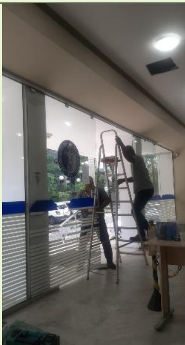
Reparo na porta do Bloco D pelos Zeladores
