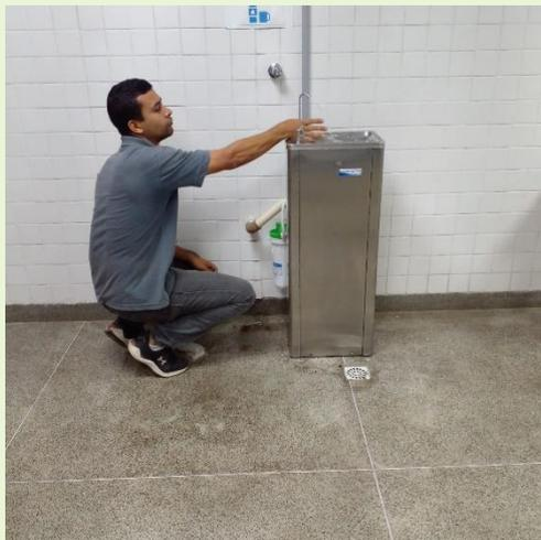
**Instalação de filtro adicional externo no bebedouro do corredor do 2º andar**
