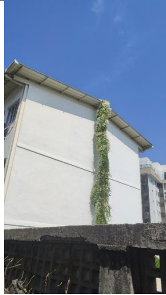
Necessidade de remoção de plantas trepadeiras invadindo as calhas dos blocos A e C
