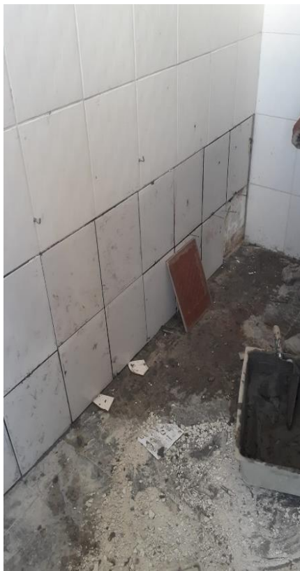
Bloco D – Em andamento a Restauração da parede do Biotério
