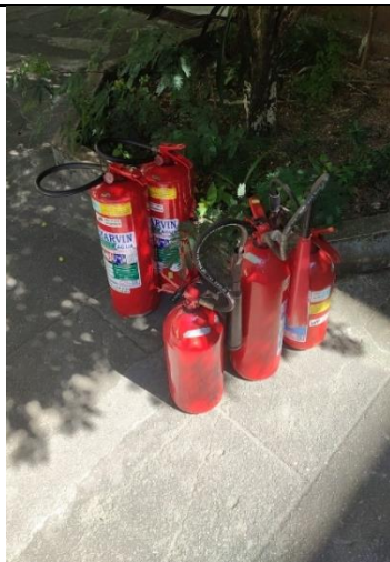
Recarga de Extintores do Bloco A pela empresa contratada.
