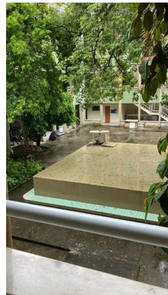
Limpeza da cisterna do Bloco A
