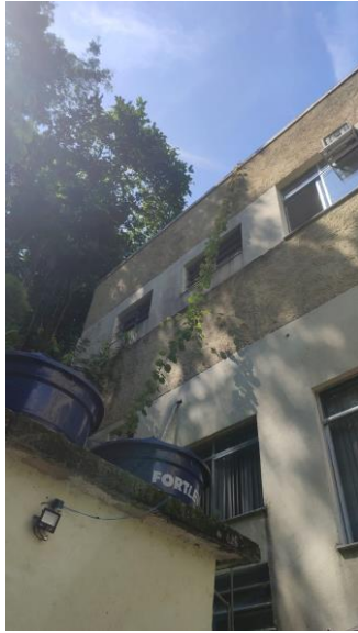
Necessidade de remoção de plantas trepadeiras invadindo as calhas dos blocos A e C
