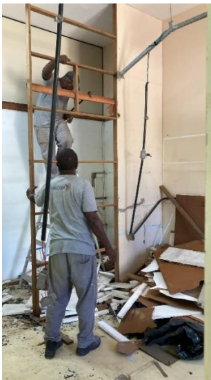
Demolição das Divisórias Lab. Bacteriomas Marinhas - Sala 304 do Bloco A
