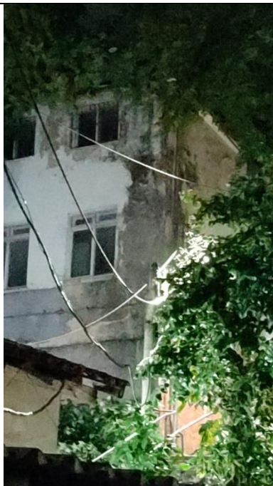
Restauração da Iluminação das Escadaria de Acesso ao Valonguinho
