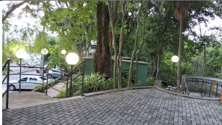
Restauração da Iluminação das Luminárias do Bloco E
