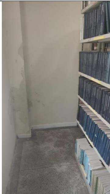
Bloco A – Sanado problema de infiltração e restaurada a parede da sala de periódicos da Biblioteca
