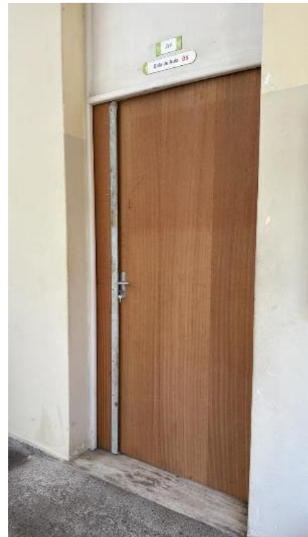
Bloco A. Substituição da Porta da Sala 5
