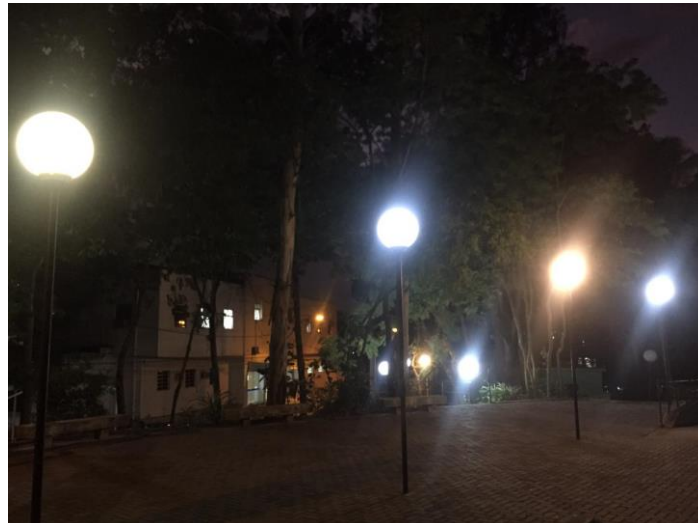
Recuperação das luminárias em frente ao Bloco E
