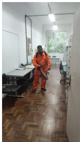
Aplicação de Quaternário de Amônio para redução de mofo nos Blocos A e E
