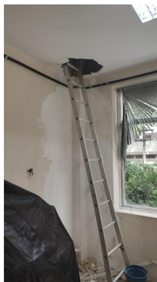
Em andamento reparo na infiltração da Sala Multimidia do MFL no Bloco A
