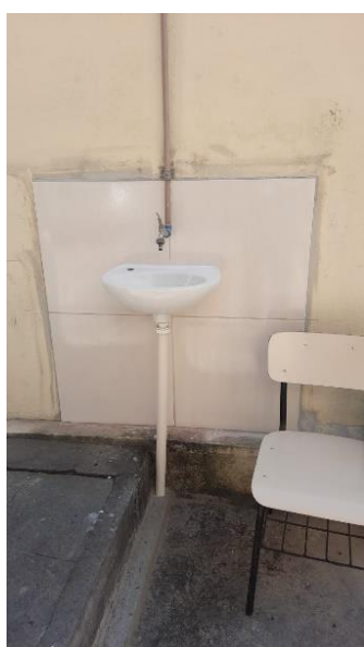
Instalação de pia anexa à Guarita do Vigilante – Bloco A
