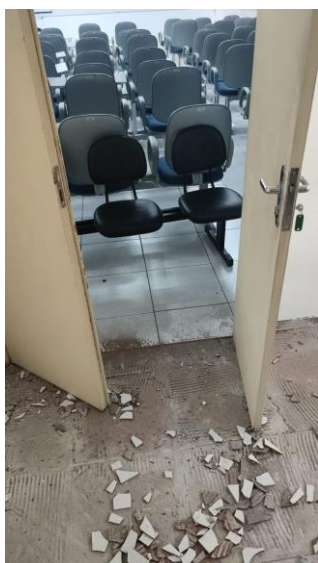
Remoção do piso solto e substituição por piso em cimento liso no 3º andar do Bloco C.
