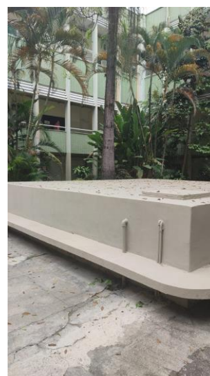
Pintura da cisterna do Pátio interno do Bloco A - SOMA/VIVACOM
