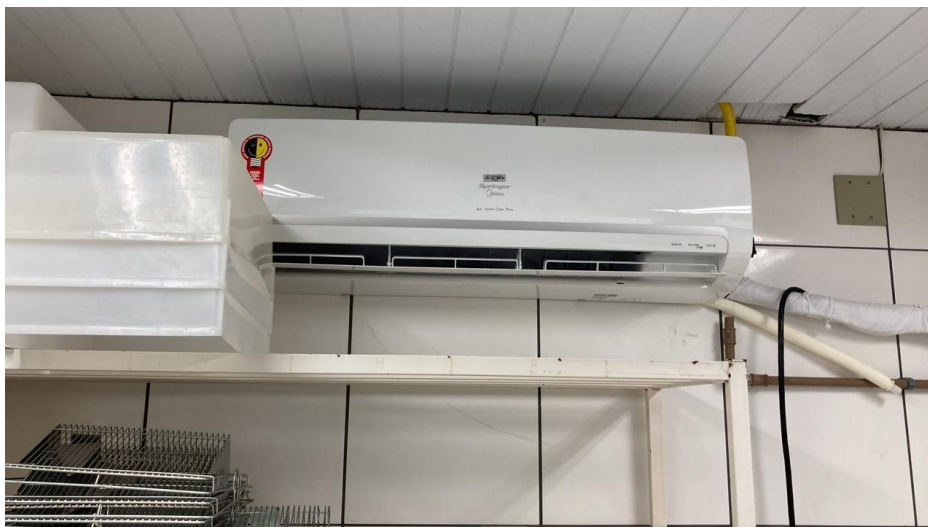
Instalação emergencial de ar condicionado no biotério (sala 208) do Bloco A PROAD/PROEX/SOMA
