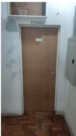
Substituição de portas danificadas por cupins.
