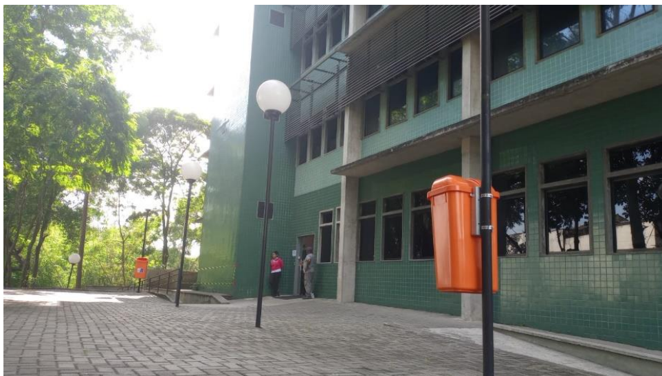
Instalação de lixeiras na área frontal do Bloco E
