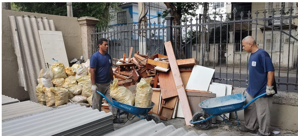
Retirada de entulho resultante de obras e reformas no Bloco A
