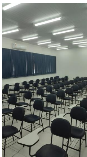
Finalização da obra de troca de piso das salas de aulas do 3º andar do Bloco C
