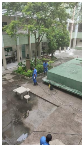
Lavagem do piso do pátio e áreas externas do Bloco A com máquina lava-a-jato – SOLL
