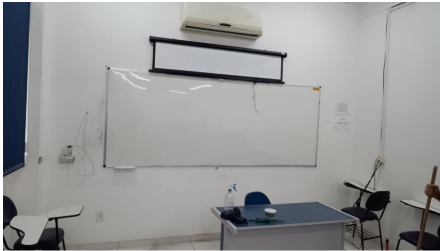
Instalação de novo quadro na sala 02 do Bloco C
