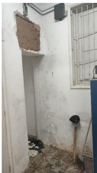
Em andamento reparo na infiltração da Antiga secretaria do MMO no Bloco A
