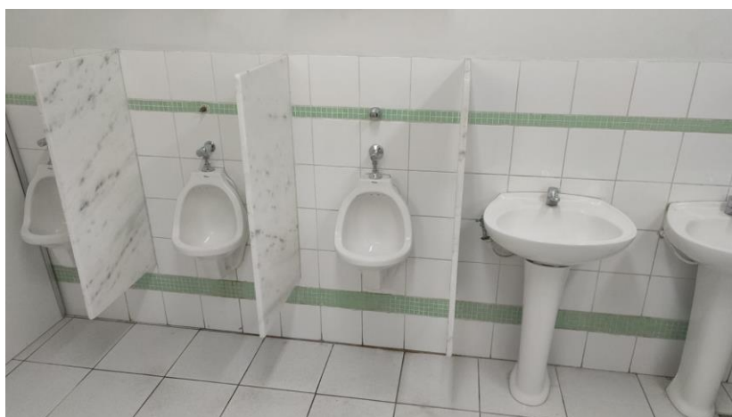
Concluídos os serviços em mictórios e pias do banheiro masculino do subsolo do Anatômico
