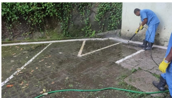
Remoção de limosidade do piso do estacionamento
