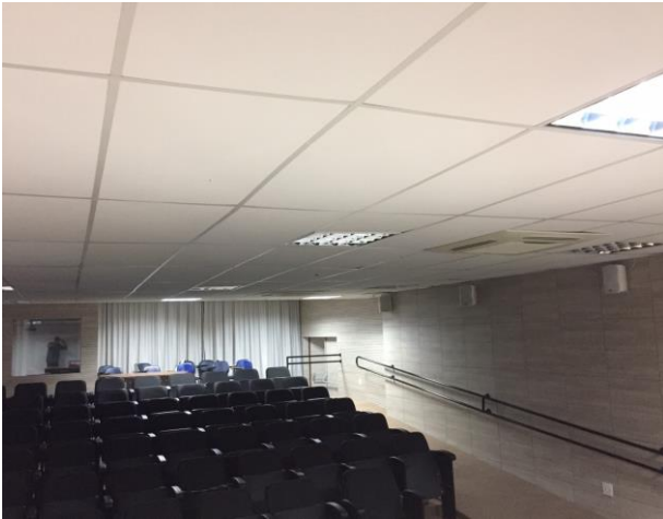
Restauração do forro do teto do auditório do Bloco E - SOMA
