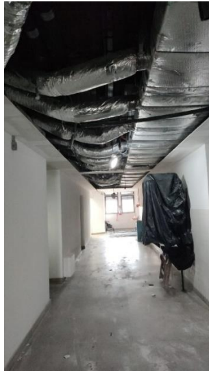
Prosseguimento a obra da troca do forro dos corredores e dos laboratórios
