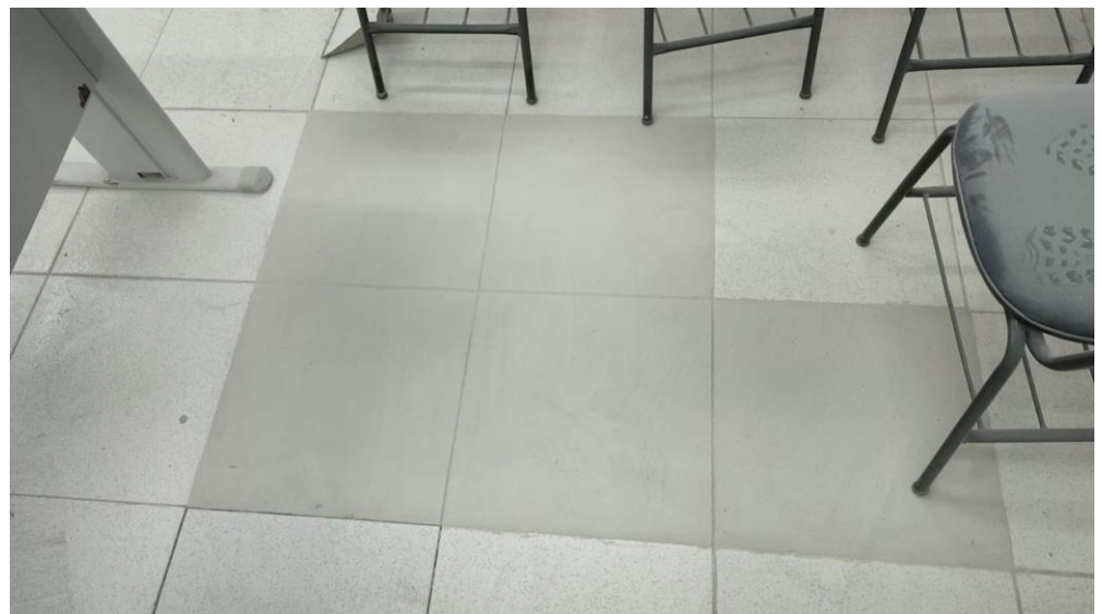
Remoção e substituição do piso solto no 3º andar do Bloco C SOMA/VIVACOM
