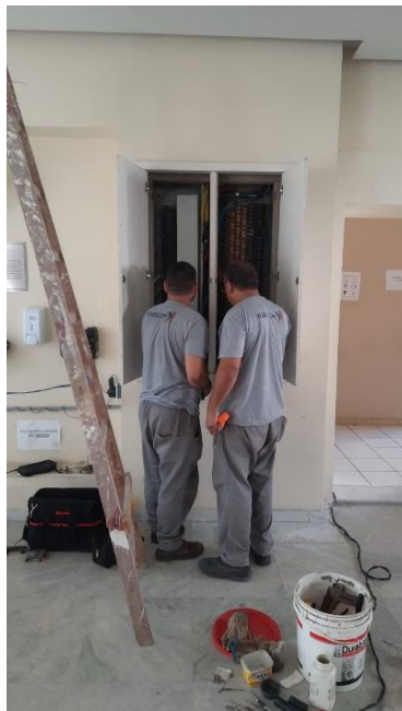
Reparos no quadro de luz do Bloco D – Anatômico
