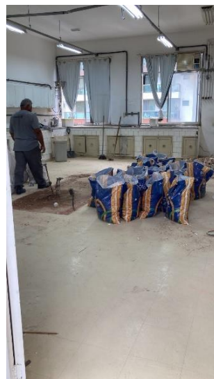
Obra de adequação da sala 311 para Biotério.
