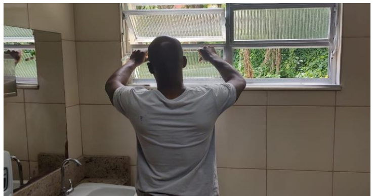
Reposição de vidros quebrados em banheiro do Bloco A na ocasião do temporal em 5/10/2023.
