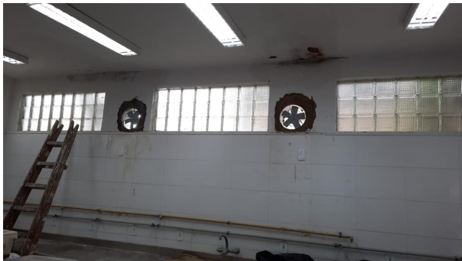
Substituição de exaustores do subsolo do Bloco D – Subsolo do Anatômico. SOMA
