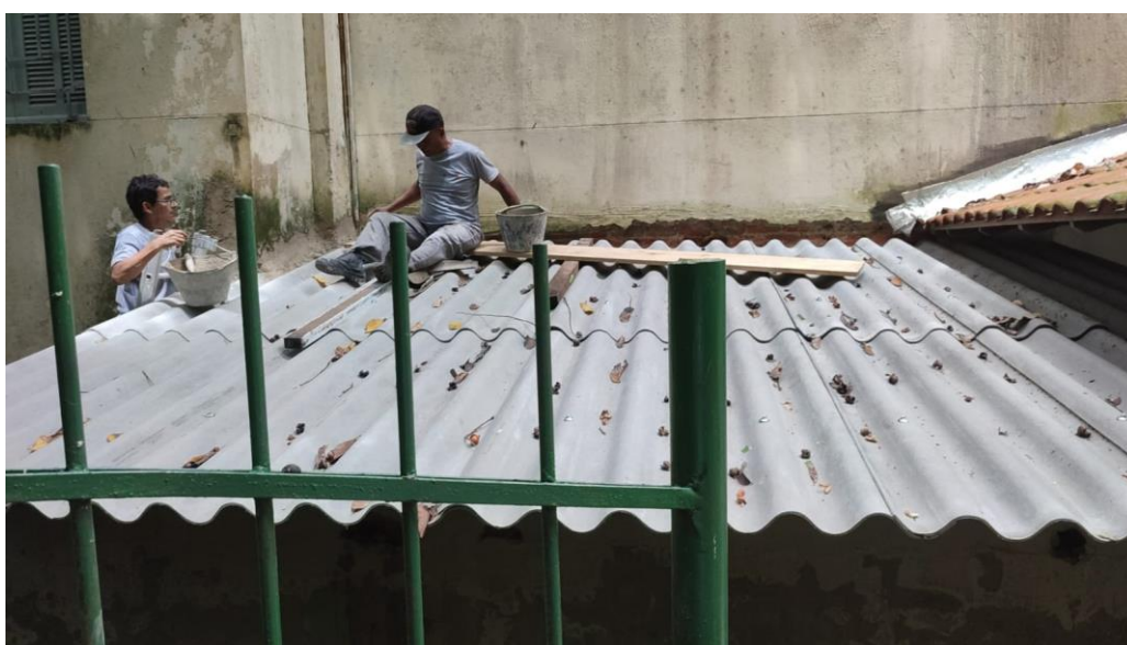
Substituição do telhado sobre os banheiros da Antiga Secretaria do MMO no Bloco A SOMA/VIVACOM
