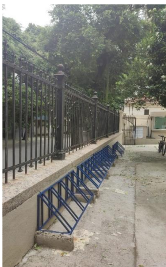
Pintura do Bicletário do Bloco A - SOMA/VIVACOM
