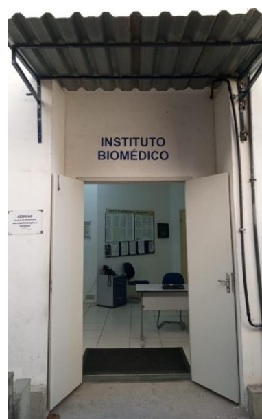
Instalação telhado de proteção na entrada do Bloco C
