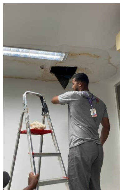
Sanado Vazamento na sala de seminários do 3º andar - SOMA
