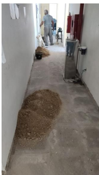
Remoção do piso solto e substituição por piso em cimento liso no 3º andar do Bloco C.
