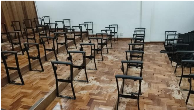
Feita retirada de encostos e assentos das poltronas do Auditório do Bloco A danificadas pelos cupins
