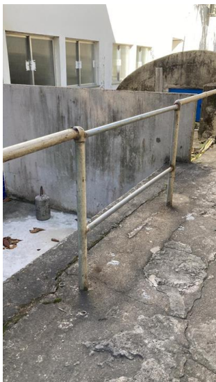
Reposição dos corrimãos no Acesso ao Bloco C. Material do CMB. Mão de obra SOMA
