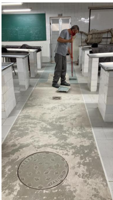
Pintura em epóxi no corredor entre bancadas no subsolo do Bloco D. SOMA
