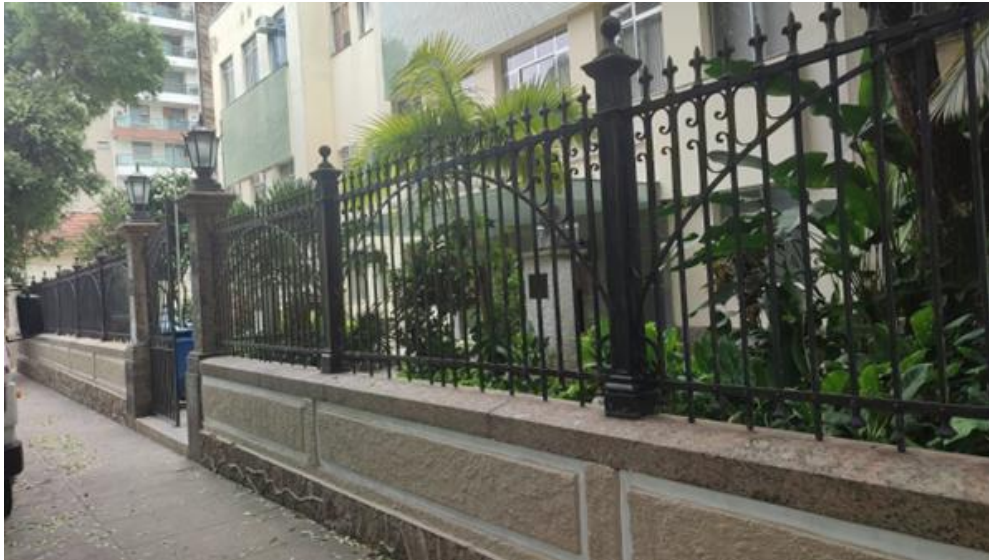
Pintura do muro frontal do Bloco A - SOMA/VIVACOM
