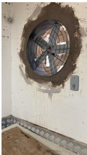
Substituição de exaustores do subsolo do Bloco D – Subsolo do Anatômico. SOMA
