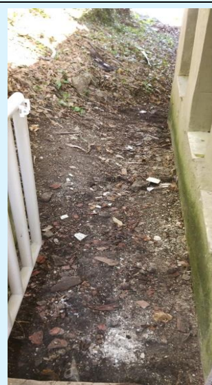
Bloco A – Serviço da SOMA: capina e retirada de terra sobre a calçada. Não resolveu o problema da Infiltração
