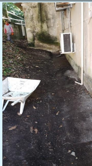
Bloco A – Serviço da SOMA: capina e retirada de terra sobre a calçada. Não resolveu o problema da Infiltração
