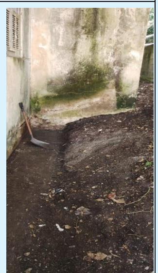
Bloco A – Serviço da SOMA: capina e retirada de terra sobre a calçada. Não resolveu o problema da Infiltração
