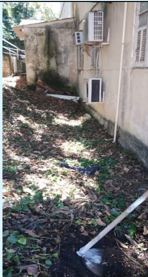
Bloco A – Serviço da SOMA: capina e retirada de terra sobre a calçada. Não resolveu o problema da Infiltração
