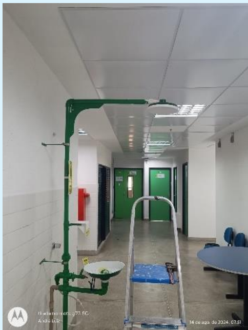
Reposição dos cheveiros de emergência do Bloco E
