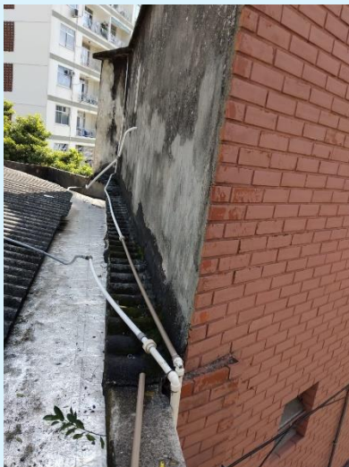
Bloco B – DST – Recuperação do fornecimento d'água com substituição de tubulação
