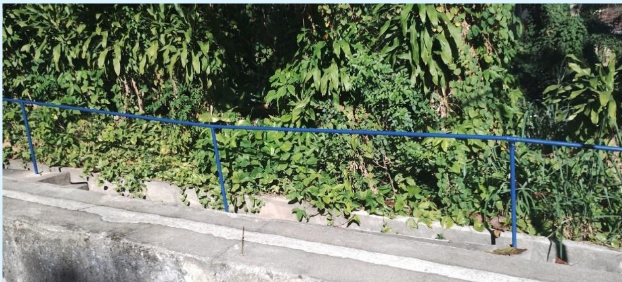
Área Externa – Reparo e pintura do corrimão da escadaria
