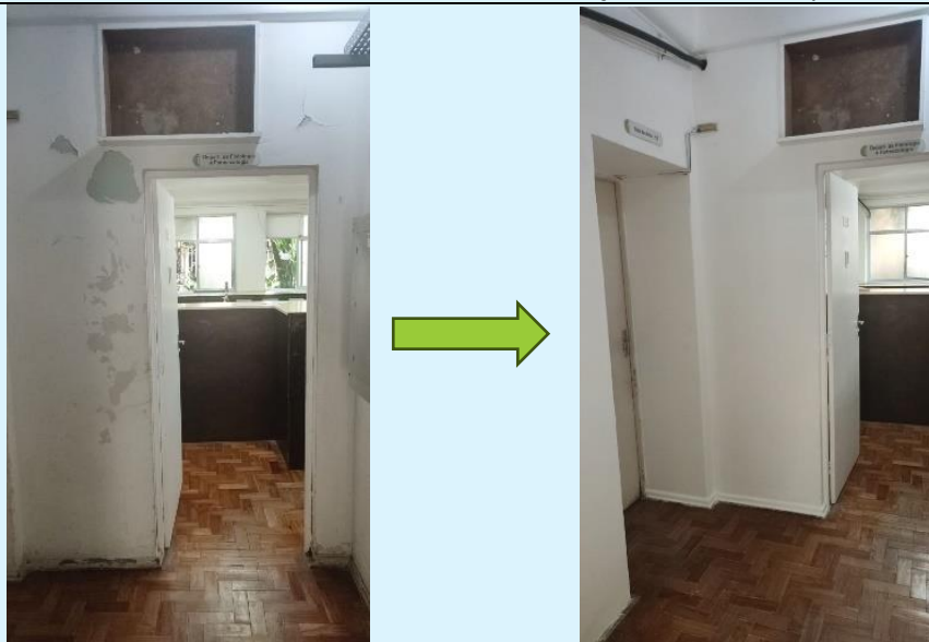
Bloco A – Pintura do Hall de Entrada do MFL e sala 11
