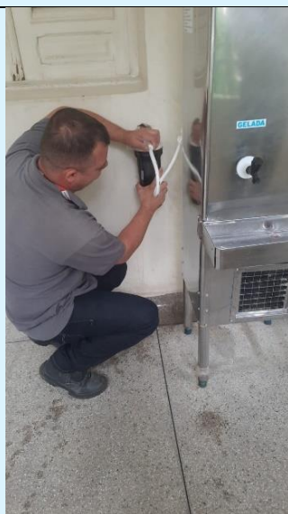
Troca de todos os filtros de bebedouros e purificadores dos espaços coletivos do CMB
