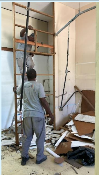
Demolição das Divisórias Lab. Bacteriomas Marinhos - Sala 304 do Bloco A
