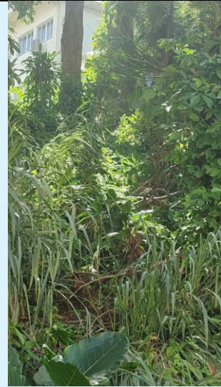
Retirada de Galhos deixados na encosta com risco de danos em veículos estacionados no Bloco A
