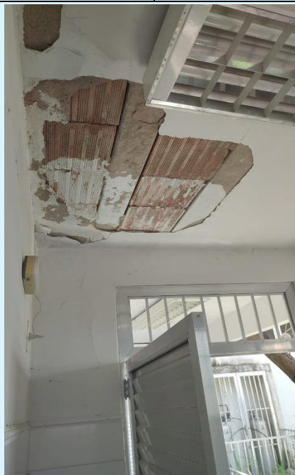
Desprendimento de revestimento de gesso e teto e rachaduras no teto de áreas do Anatômico
