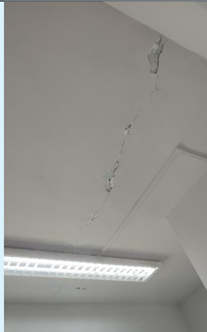
Desprendimento de revestimento de gesso e teto e rachaduras no teto de áreas do Anatômico
