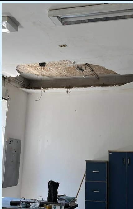
Desprendimento de revestimento de gesso e teto e rachaduras no teto de áreas do Anatômico
