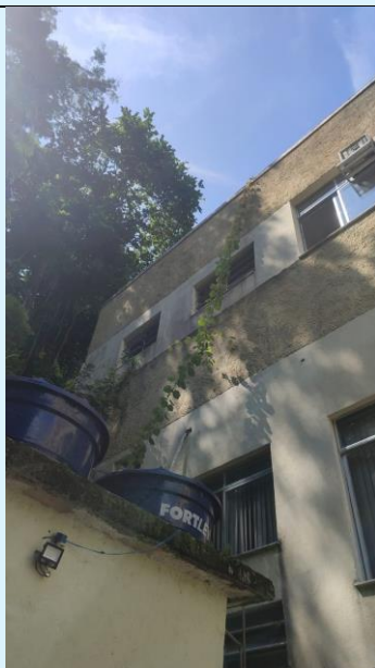
Necessidade de remoção de plantas trepadeiras invadindo as calhas dos blocos A e C
