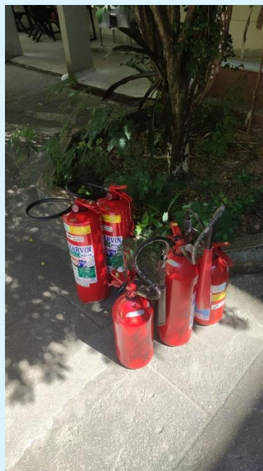
Recarga de Extintores do Bloco A pela empresa contratada.
