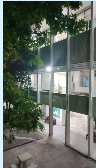
Restauração da Iluminação Interna do Pátio Central do Bloco A
