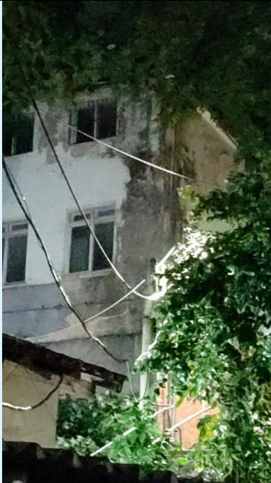
Restauração da Iluminação das Escadaria de Acesso ao Valonguinho
