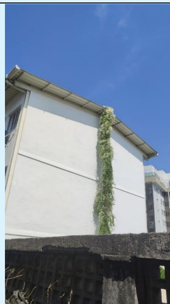
Necessidade de remoção de plantas trepadeiras invadindo as calhas dos blocos A e C
