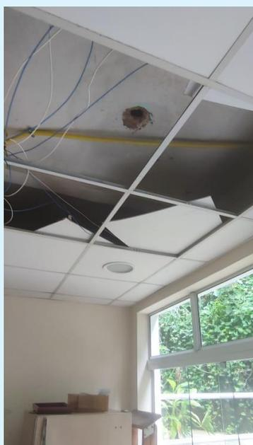
**Vazamento na laje da área de coffee break do Bloco A.**
