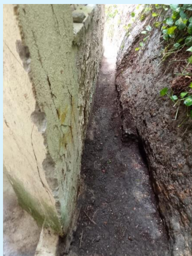
Limpeza da calha de drenagem de águas da encosta no estacionamento.
