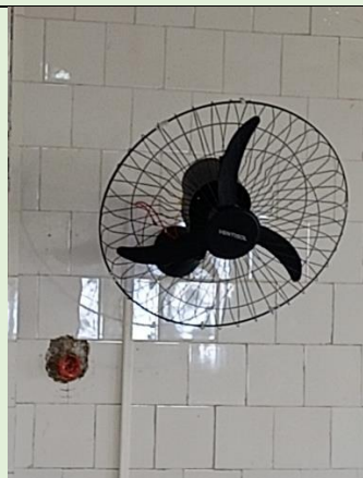
Corte de fio de um dos ventiladores do Anatômico – Inaceitável.
