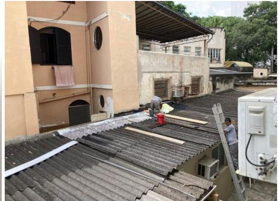
**DAJUP - Pintura interna e Colocação de manta de impermeabilização no telhado.
