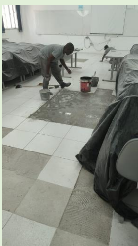
Remoção e substituição do piso solto no 3º andar do Bloco C SOMA/VIVACOM
