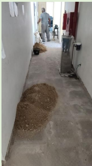
Remoção do piso solto e substituição por piso em cimento liso no 3º andar do Bloco C.
