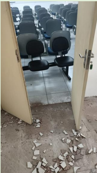
Remoção do piso solto e substituição por piso em cimento liso no 3º andar do Bloco C.
