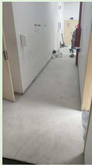
Remoção do piso solto e substituição por piso em cimento liso no 3º andar do Bloco C.
