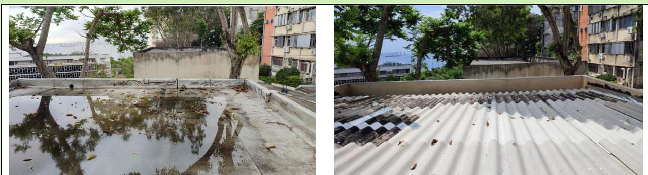
**Instalação de cobertura sobre Lage com infiltrações crônicas – Bloco D-CMB**
