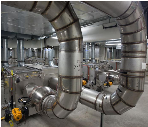
Sistema de filtro HEPA
