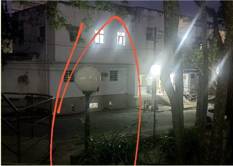
MANUTENÇÃO: Troca de lâmpadas queimadas – Bloco E
