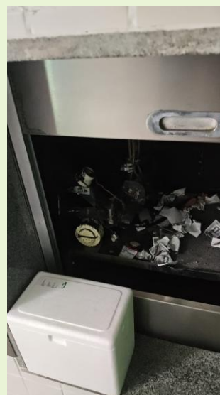
BLOCO E - Flagrante de monta-carga fora de operação Sem ciência da Direção e de descarte inadequado de caixa isotérmica
