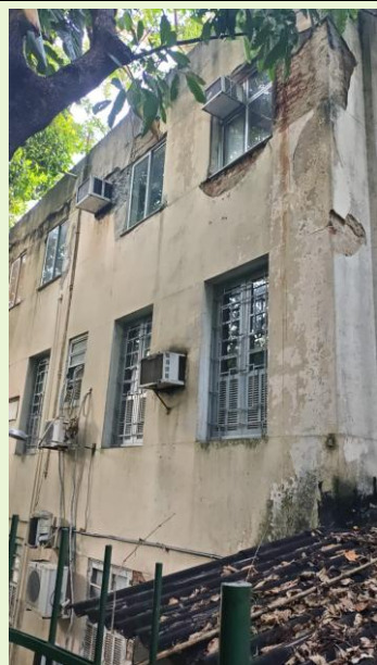
Situação de gravidade dos suportes dos equipamentos de Ar-condicionado da Unidade 20 pedidos em aberto aguardando atendimento da SOMA
