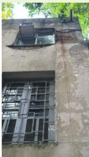
Situação de gravidade com desprendimento de reboco e desgaste de janelas na Fachada de fundos do Anexo do Bloco A
