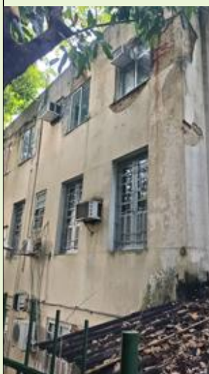
Situação de gravidade com desprendimento de reboco e desgaste de janelas na Fachada de fundos do Anexo do Bloco A
