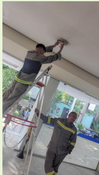
Reposição de Plafons das luminárias do Hall de entrada do Anatômico
