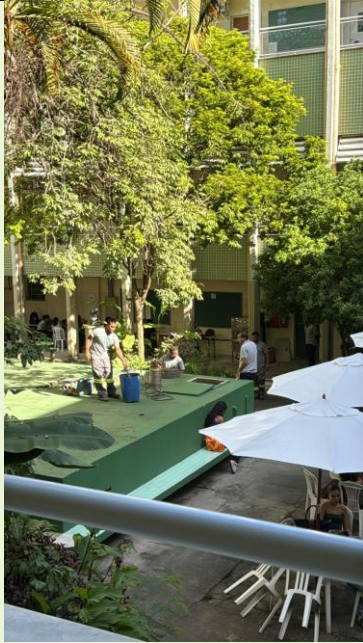
Encerrada a operação de lavagem de todas as caixas d'água e cisternas da Unidade
