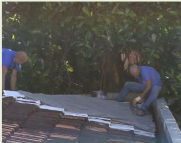
Em andamento a impermeabilização de todo o telhado do Anexo do Bloco A com recursos da Livre Ordenação de 2025
