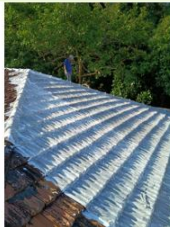
Em andamento a impermeabilização de todo o telhado do Anexo do Bloco A com recursos da Livre Ordenação de 2025
