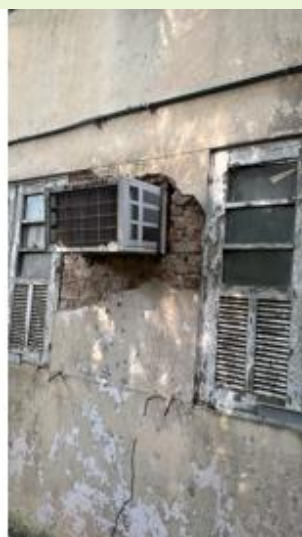
Situação de gravidade com desprendimento de reboco e desgaste de janelas na Fachada de fundos do Anexo do Bloco A
