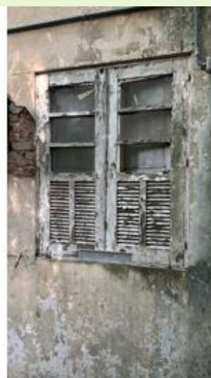
Situação de gravidade com desprendimento de reboco e desgaste de janelas na Fachada de fundos do Anexo do Bloco A
