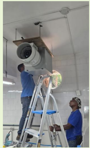
Projeto de Revitalização das áreas de ensino do MMO Instalação de ar-condicionado, instalação de filtros de ar, nova instalação elétrica
