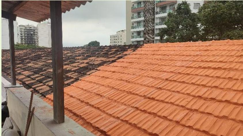
**Restauração com impermeabilização de parte do telhado do Bloco A**
